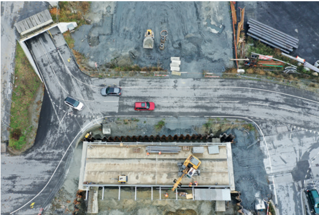
Hilfsbrücke beim Bahnhof im Bau, enge Strassenführung absehbar
